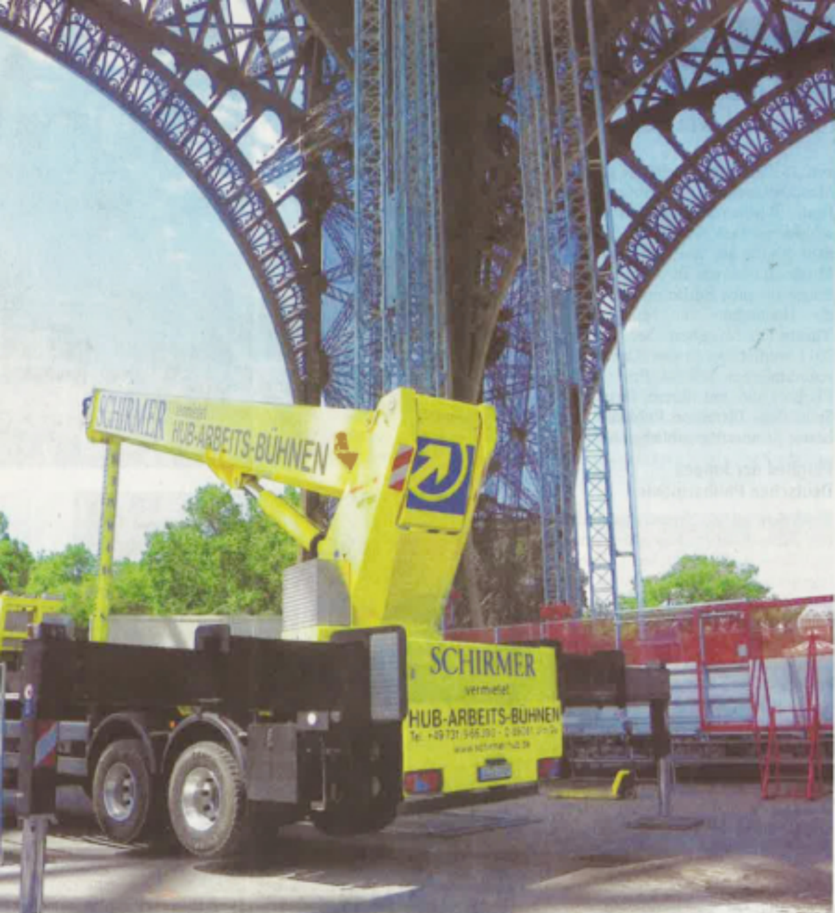
Ulmer Besuch in Paris: Eine Hub-Arbeitsbühne der im Stadtteil Jungingen ansässigen Firma Schirmer ist derzeit bei der Montage eines Lastenaufzugs im Eiffelturm beteiligt. Foto: Roland Mayer
