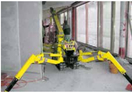
Glaseinbau bei beengten Platzverhältnissen
