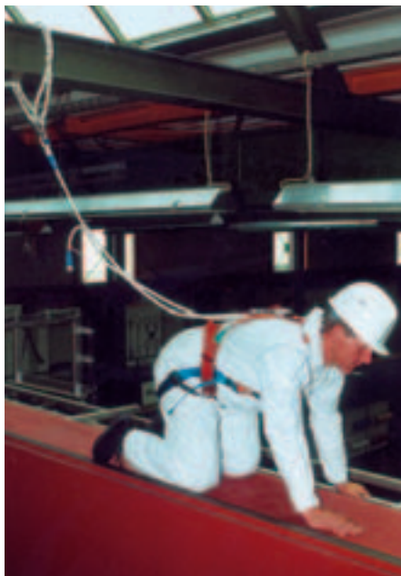
Bild 2-12: Verbindungsmittel mit Reibungsfalldämpfer
