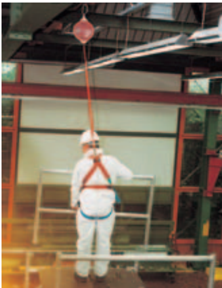
Bild 2-20: Höhensicherungsgerät im Einsatz
