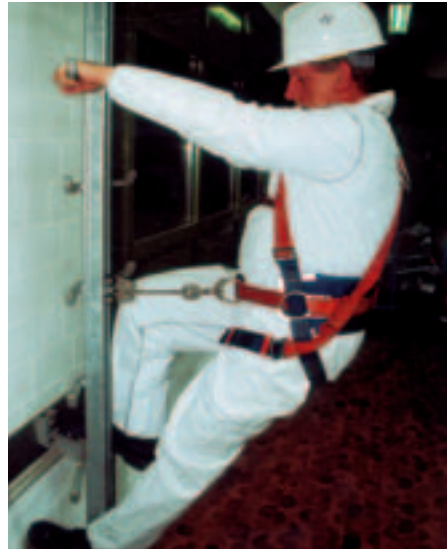
Bild 2-21: Mitlaufendes Auffangergerät an fester Führung
