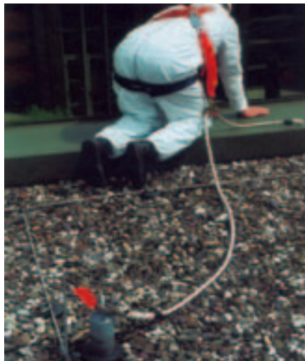
Bild 1-6: Benutzung von PSA gegen Absturz, Beispiel 5
