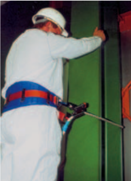
Bild 2-30: Haltegurt mit einkürzbarem Verbindungsmittel
