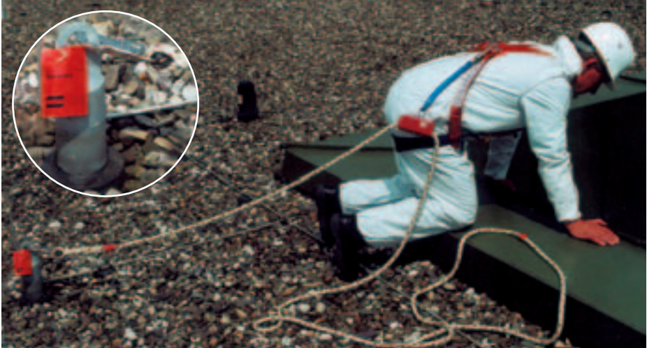
Bild 2-14: Anschlagpunkt auf einem Flachdach
