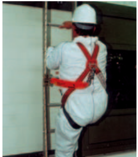
Bild 2-24: Mitlaufendes Auffanggerät an beweglicher Führung mit Bandfalldämpfer
