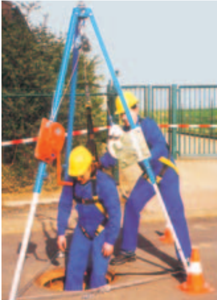
Bild 5-1: Rettung mittels Rettungshubgerät
