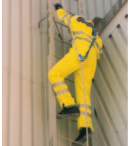
Bild 2-5: Auffanggurt im Overall integriert
