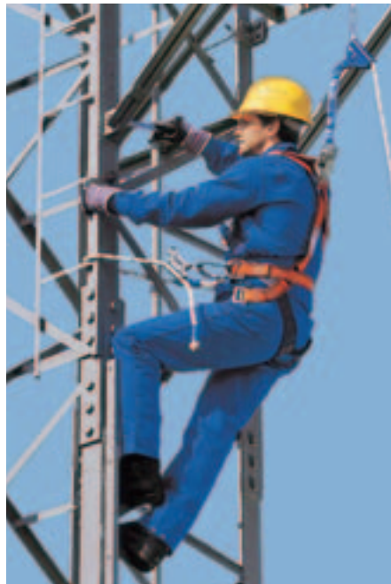
Bild 2-27: Kombination aus Auffanggurt (hier an einem mitlaufenden Auffanggerät an beweglicher Führung) und Haltegurt (mit einkürzbarem Verbindungsmittel)
