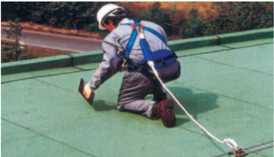
Bild 2-17: Anschlagseinrichtung als horizontale Führung
