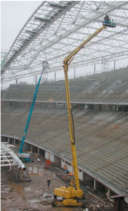
Bild 6-2: Hubarbeitsbühne im Baustelleneinsatz
