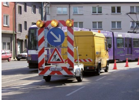
Bild 4-8: Sicherung gegen Gefährdungen des öffentlichen Straßenverkehrs
